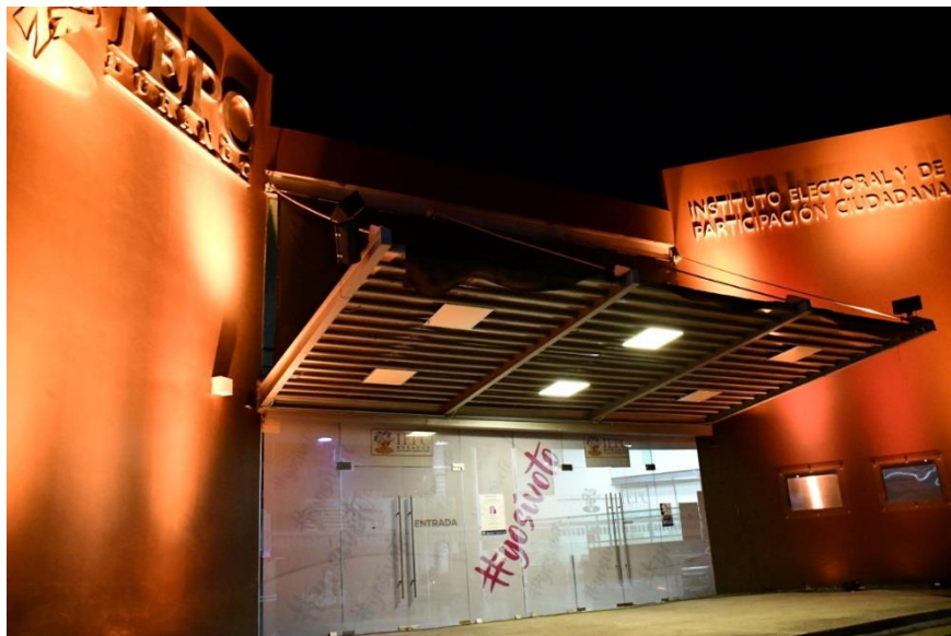
Imagen: Edificio IEPC Durango, iluminado de color naranja.
